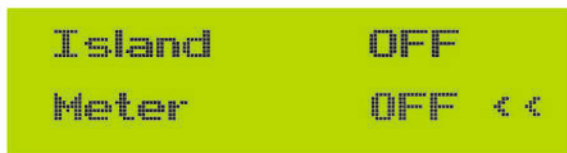
Pic 7.18 Meter switch
